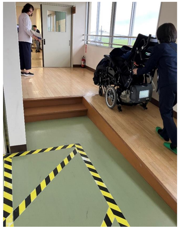
3階 音楽室に向かう廊下の段差解消スロープ
